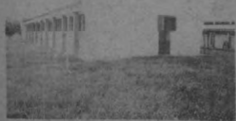
Colegio Agropecuario de Santa Cruz. Costado noroeste del Internado Femenino, en etapa de construcción.
