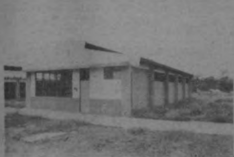
Colegio Agropecuario de Guácimo. Vista parcial del costado sur del edificio para la Bodega de Cosechas, en etapa de construcción.
