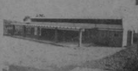
Colegio Agroindustrial de San Carlos. Vista parcial (costado sureste) del edificio para Taller de Mecánica Agrícola, se observa también el Patio de Maniobras, terminado.
