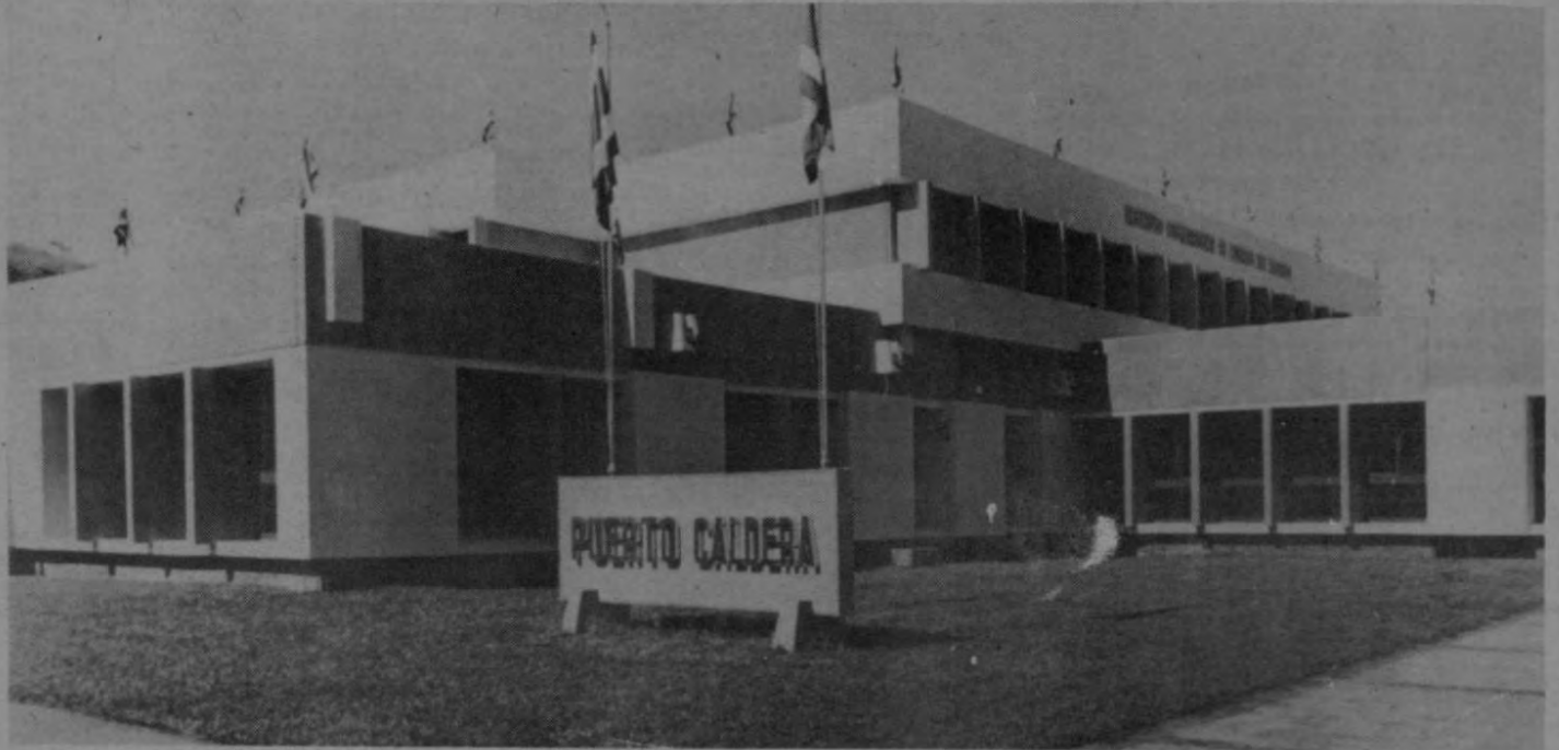
Oficina de administración en Caldera. En el edificio también se localizan diferentes agencias aduanales para trámites de importación y exportación.
