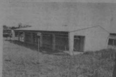
Colegio Agroindustrial de San Carlos. Costado sureste del edificio de aulas, terminado.
