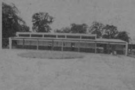
Colegio Agropecuario de Guácimo. Vista parcial del edificio para Laboratorios, costado norte, en etapa de construcción.
